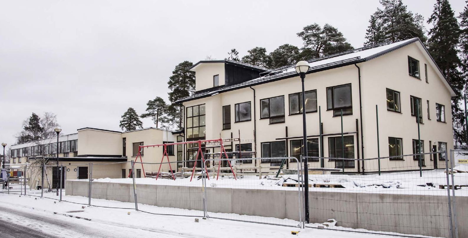
Förskolan under ombyggnationen, bilden är tagen 11 januari.
