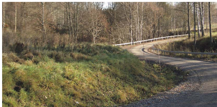
Befintliga grusade vägar, vägstandarden är överlag låg.
