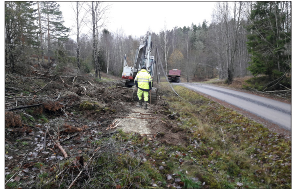
Schaktning inom objekt 8/L1984:4152/Lilla Malma 95:1. Bilden tagen från N. Foto: Ingeborg Svensson 2018, Sörmlands Arkeologi AB.
